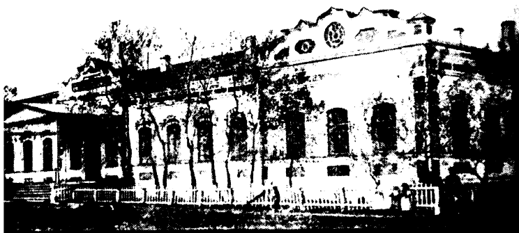
Старое здание сш №2 (ул. Булаевского)
